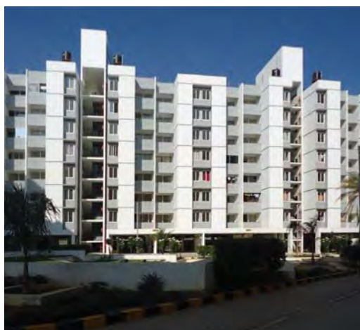
经过EDGE认证的某住宅项目，由印度的VBHC公司建造，位于班加罗尔
