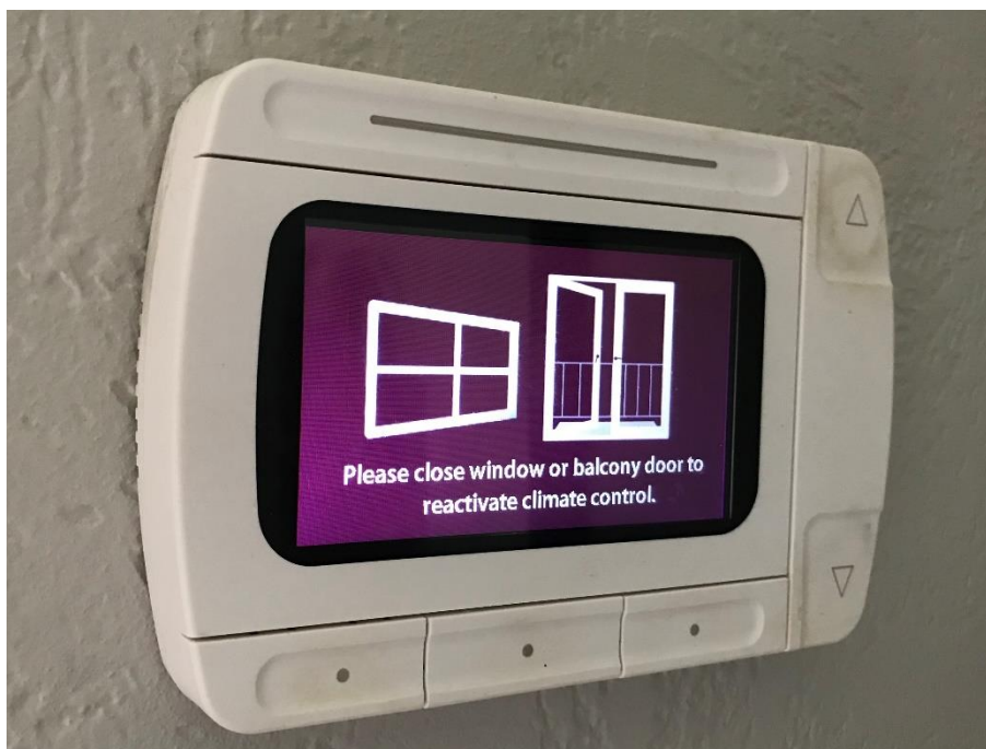
Figure 18. Dispositif de contrôle/d'arrêt automatique de la climatisation sur la base de la ventilation naturelle
