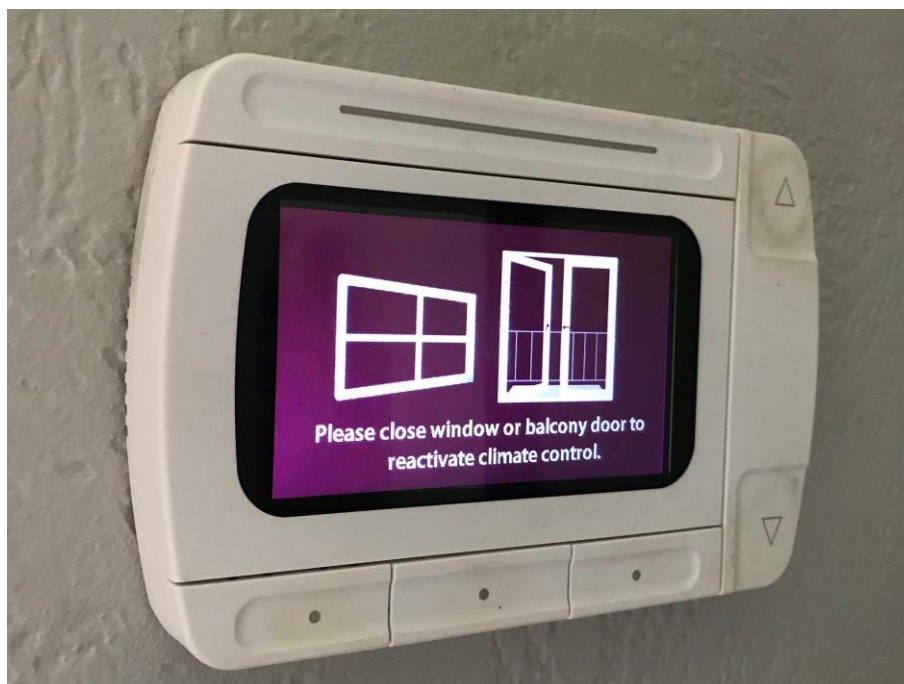
Hình 18. Điều khiển tự động tắt điều hòa không khí dựa trên thông gió tự nhiên
